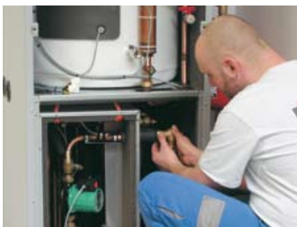
Raccorder le modulbox.
