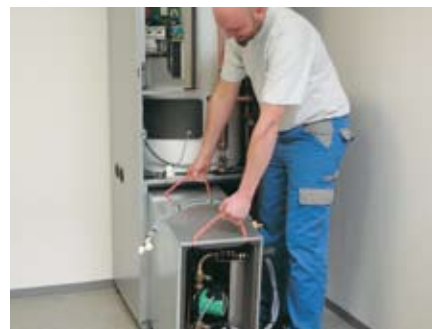
Encastrer le modulbox dans l'appareil.
